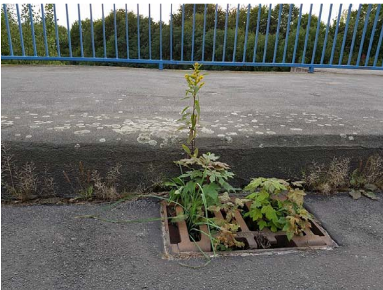
In Bürgerversammlungen werden häufig die Betriebskonzepte zur Reinigung von Straßenabläufen bemängelt, wenn über Starkregenvorsorge diskutiert wird.
